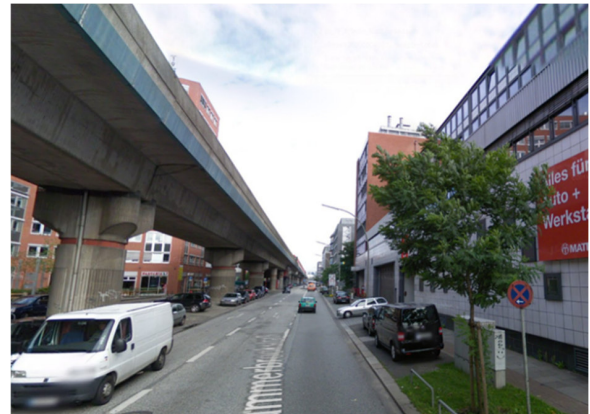
Abbildung 10: Hamburg Hammerbrookstraße 97, Stadtbahnbrücke (Google Street View)
